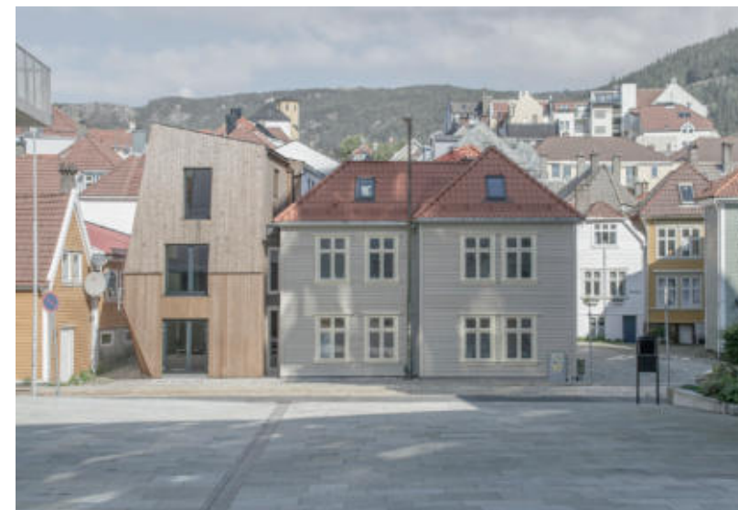
Rehabilitering og nybygg Bergen, ARK: Opaform
