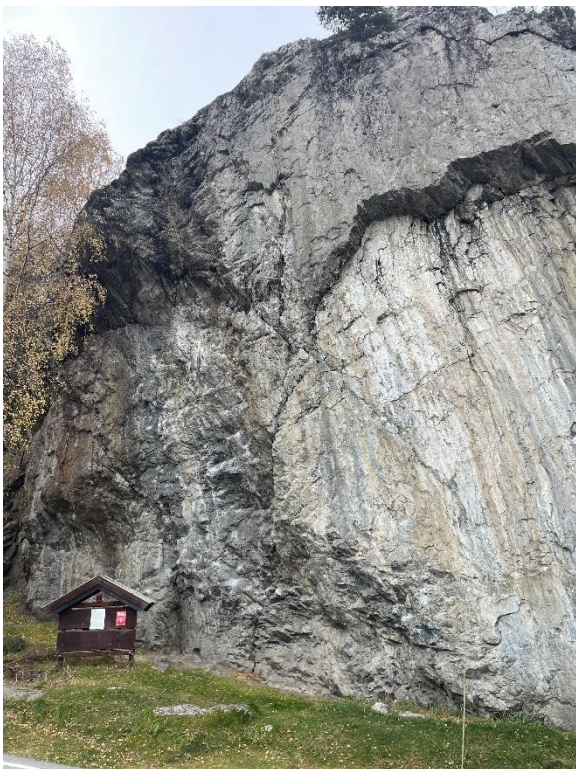
Figur 6: Skrent nordøst for tunet Jutulheimen i påvirkningsområdet. Mindre bergparti er overhengende.
