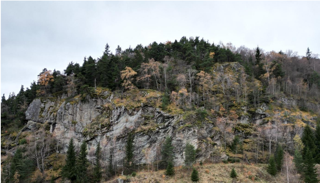
Figur 5: Skrent i nordlig del av det vurderte området. Berg er preget av høy grad av deformasjon og oppsprekking.
