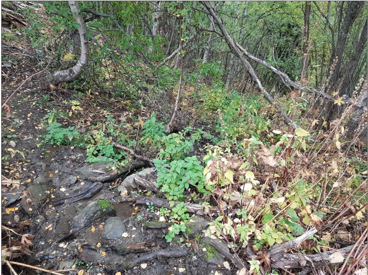
Figur 17: Skråninga der stikkrenna har utløp. Ingen godt definert kanal i skråninga og vanskeleg å kartlegga dreneringsvegen vidare nedover. Der er eit tynt lausmassedekke i skråninga som viser at det er utvasking på grunn av vatnet, men ingen spor etter større utrasingar.
