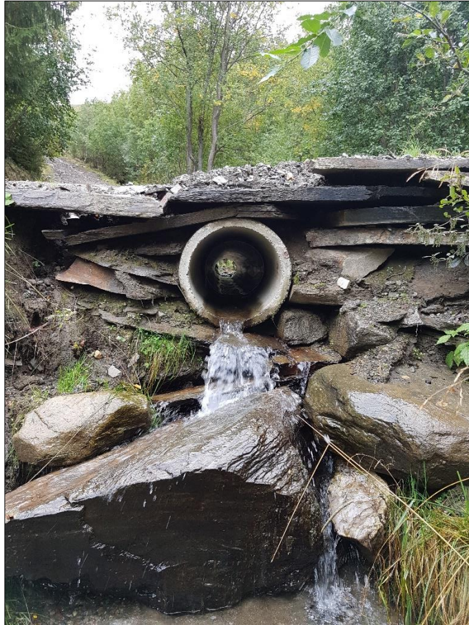
Figur 18: Kritisk punkt nr 1. Kulvert under Liasætervegen ved Søre Liasætrin.
