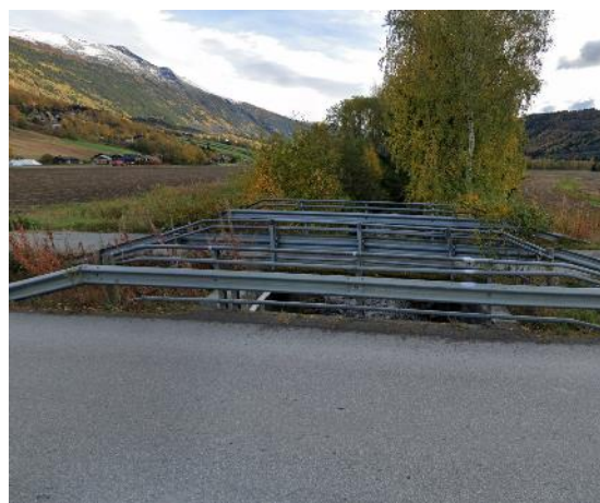
Figur 7-4: Bruer ved Industrivegen sett nedstrøms retning (Foto fra Street view, Google Maps)
