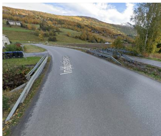
Figur 7-3: Bruer ved Industrivegen sett fra sør mot nord (Foto fra Street view, Google Maps)
