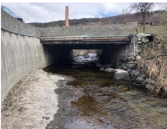
Figur 7-2: Bru ved Vågåvegen. Nedstrøms side
