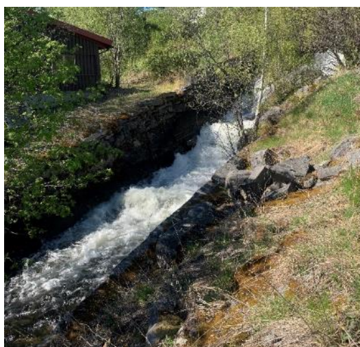
Figur 6-10: Forbygning og kanalisering ved tverrprofil NP19.
