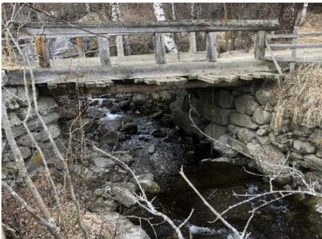
Figur 6-4: Bru rett oppstrøms Haugøy. Lysåpning BxH = 4,3 m x 1,7 m. Foto: Kai Fjelstad, HydraTeam AS.
