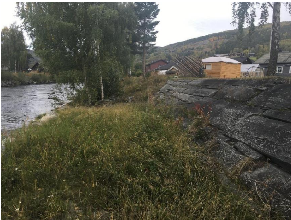
Figur 4-11 Eldre del av flomverket, Finnas østside, nedenfor Kirka
