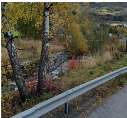
Figur 6-7: Forbygning langs Øygardsvegen. Foto fra Streetview, Google Maps
