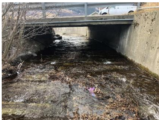
Figur 7-1: Bru ved Vågåvegen. Oppstrøms side
