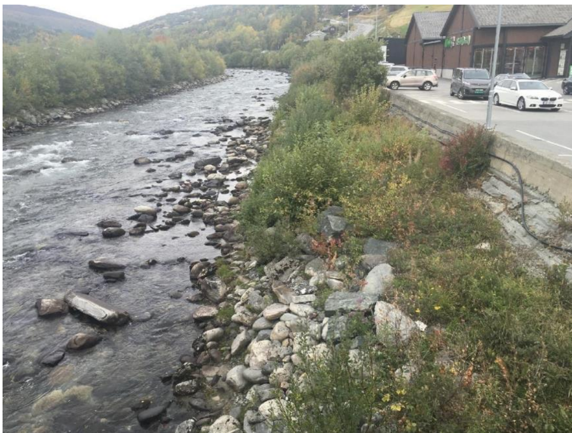
Figur 4-8 Lav mur på topp av gammelt flomverk ved Kiwi butikken, rett oppstrøms Finna bru.
