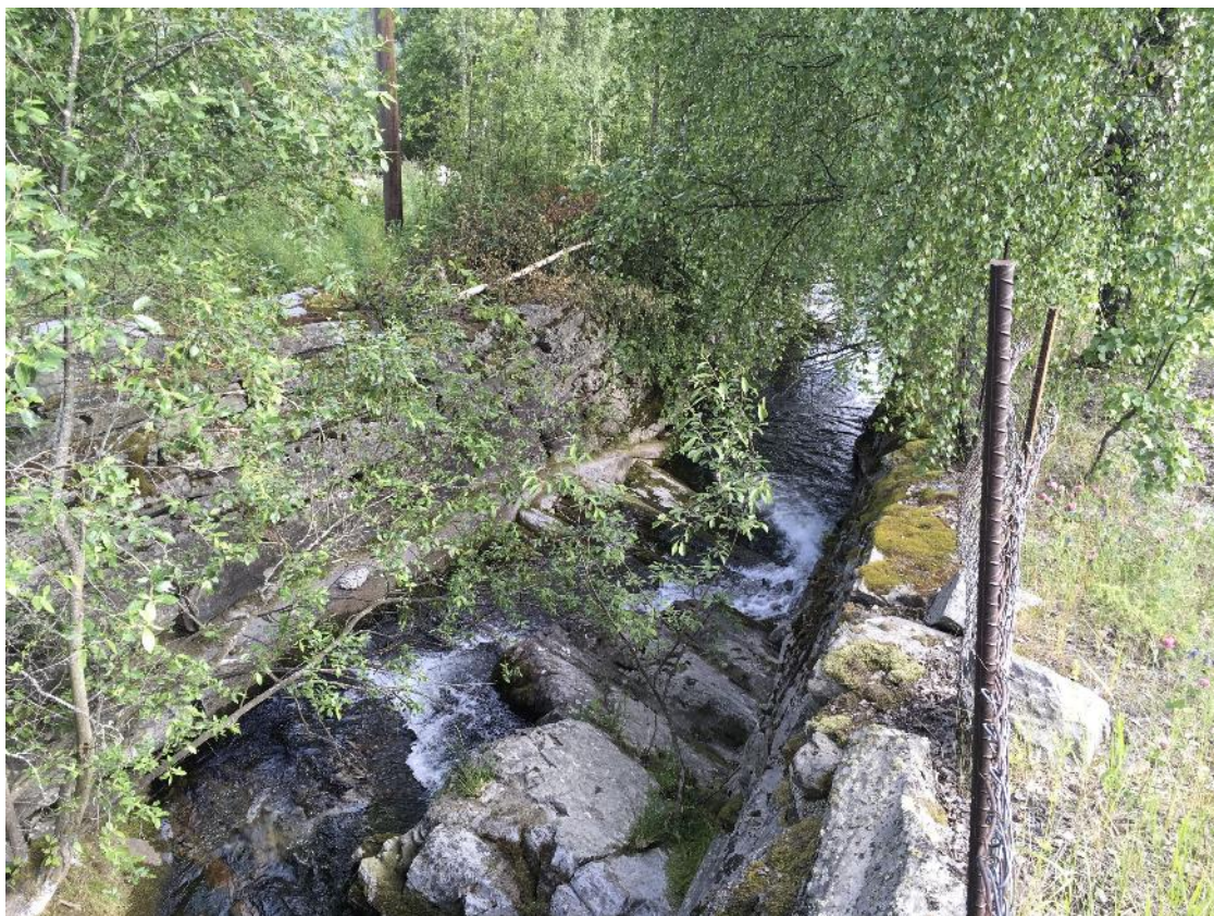
Figur 6-6 Nugga øst for svingen i Øygardsvegen, ca. ved punkt NP14 (Figur 6-5). Her er hovedsakelig berg i bunnen og tørrmurte sider
