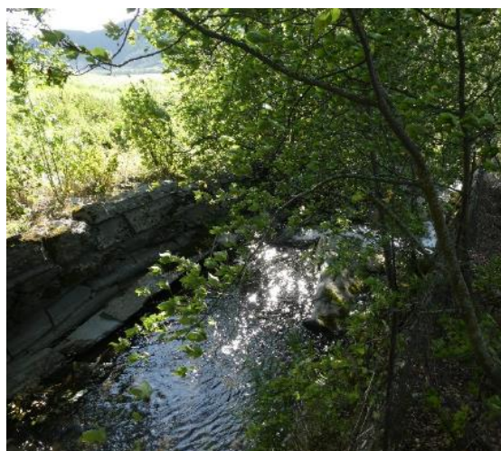
Figur 6-8: Forbygning ved tverrprofil NP14.
