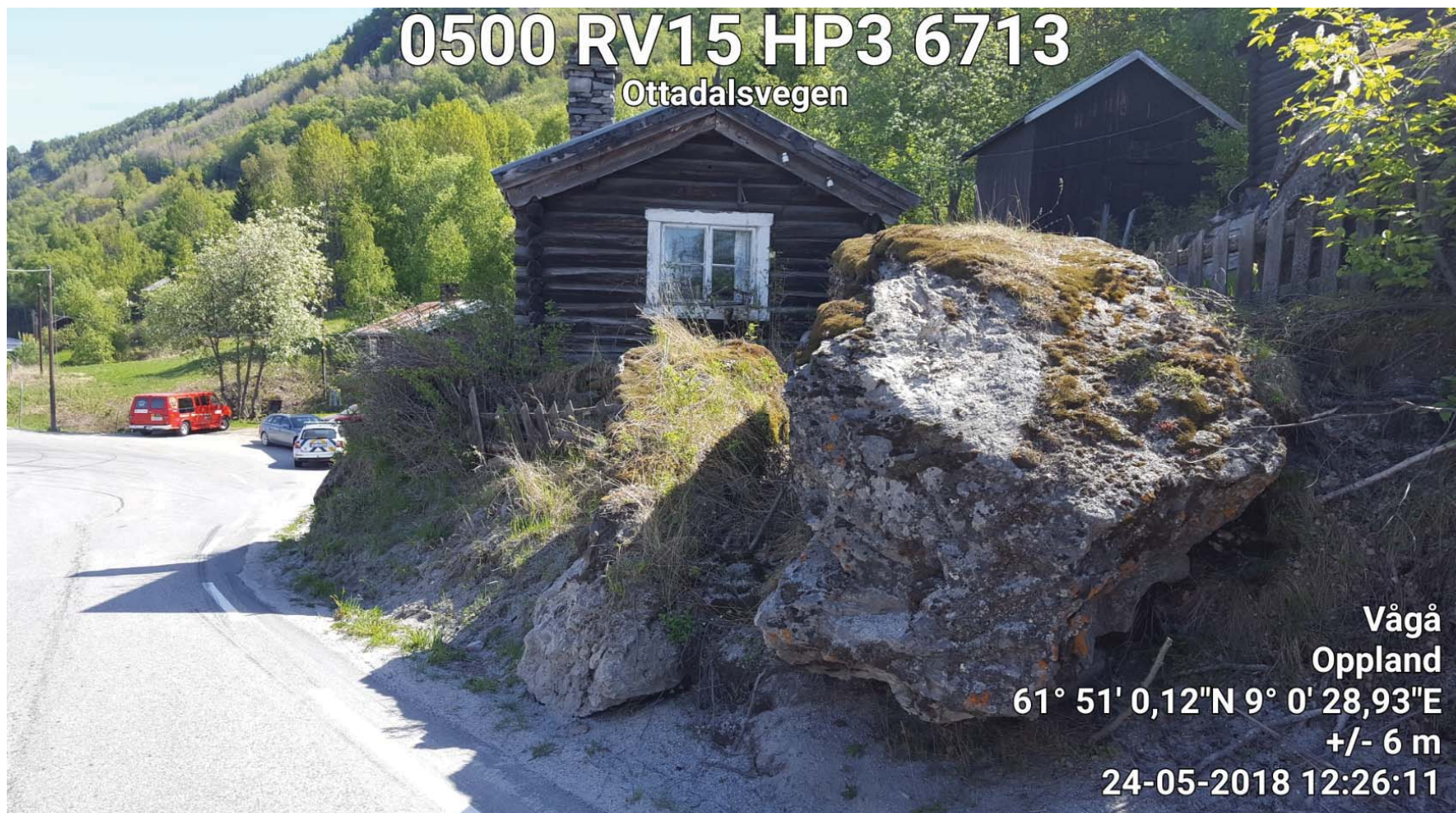
Foto 10. Blokker som potensielt kjem av tidlegare steinsprang. Fotoet er teke rett i overkant krysset rv. 15 x fv. 51.
