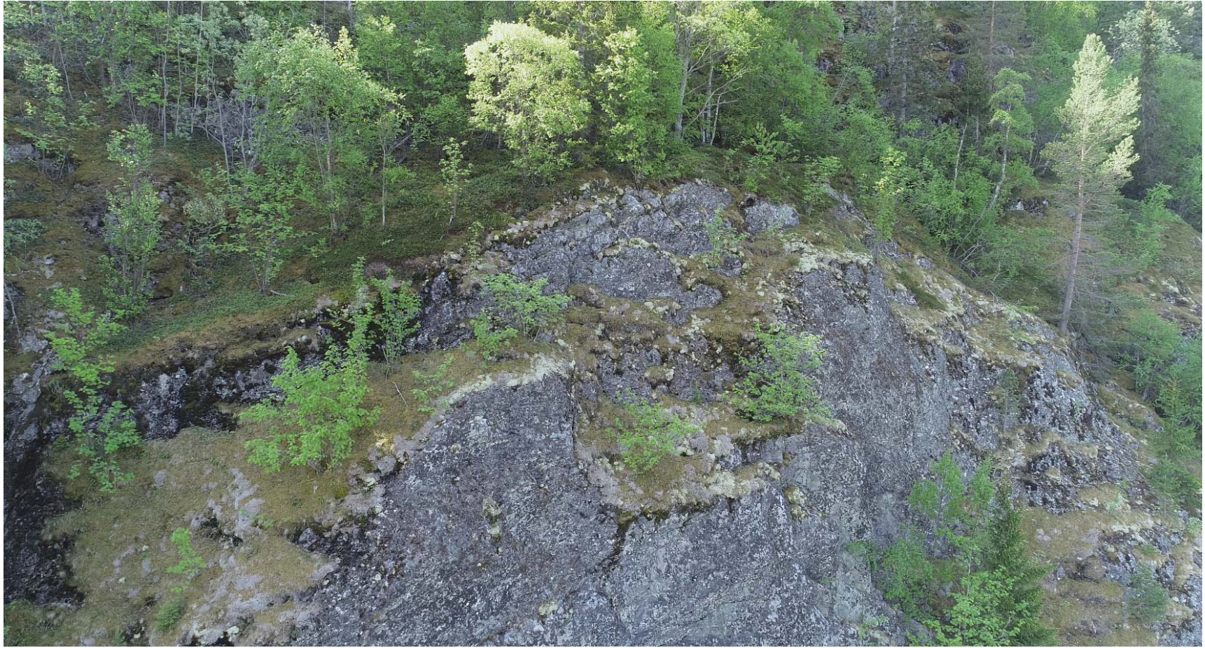
Foto 3. Nærfoto av midtre del av Foto 2. Berget er generelt massivt, med stadvis mindre oppsprekking. Massivitet/oppsprekking på dette fotoet er også relativt typisk for andre delar av bergpartia i skråninga.
