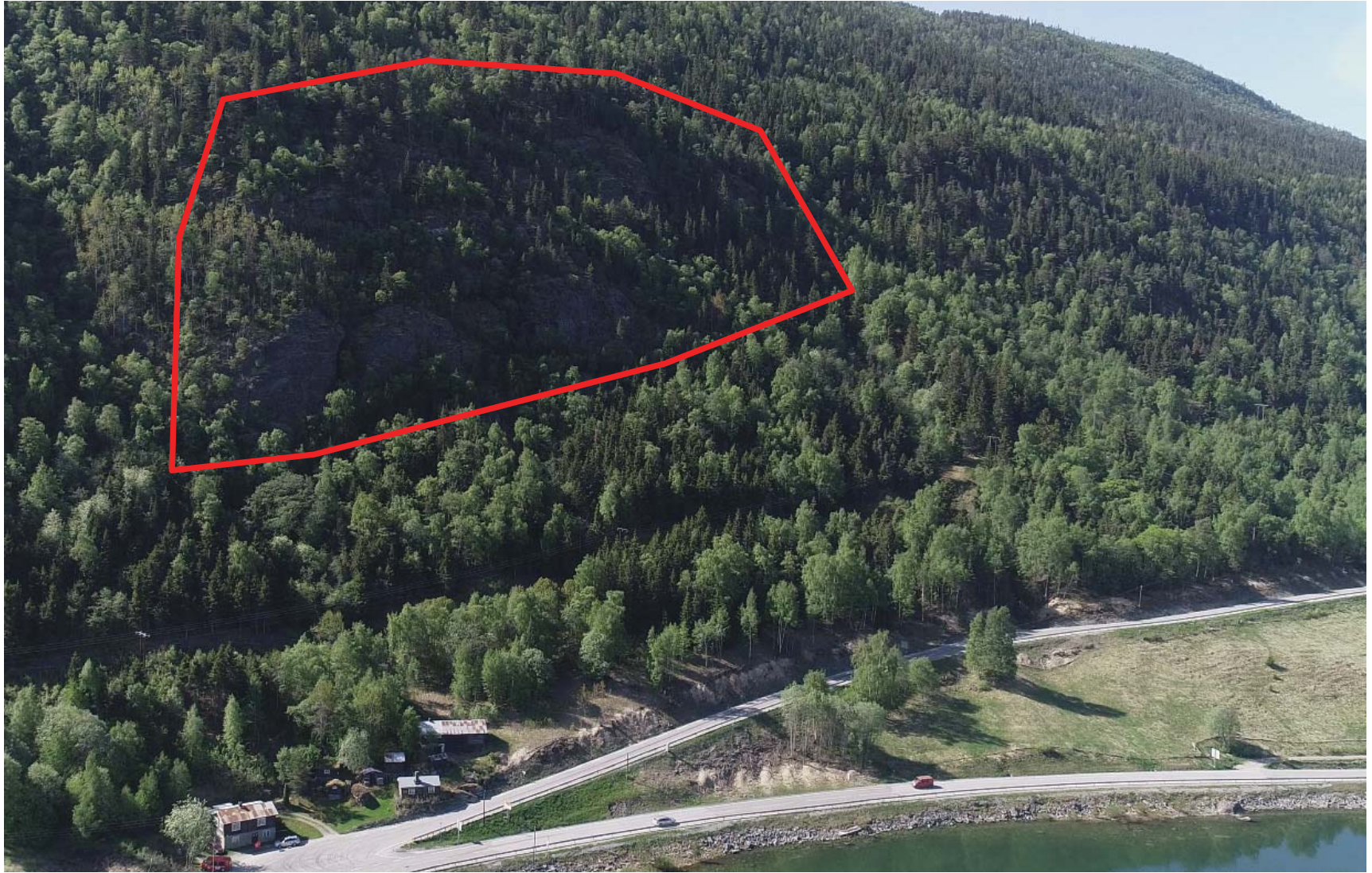
Foto 1. Oversiktsfoto over eit av dei utsette områda med tanke på steinsprangfare. Område innanfor raud firkant vart synfart nærare, sjå mellom anna Foto 2, 3 og 4.
