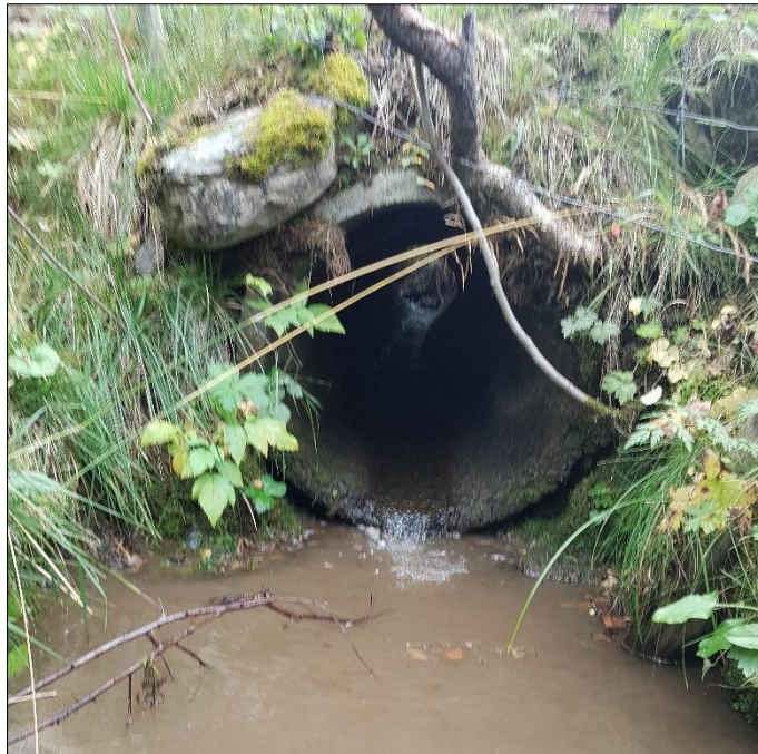
Figur 19: Kritisk punkt nr 2. Kulvert under sti/traktorveg ved sørlege ende av dyrka mark på Søre Liasætrin.
