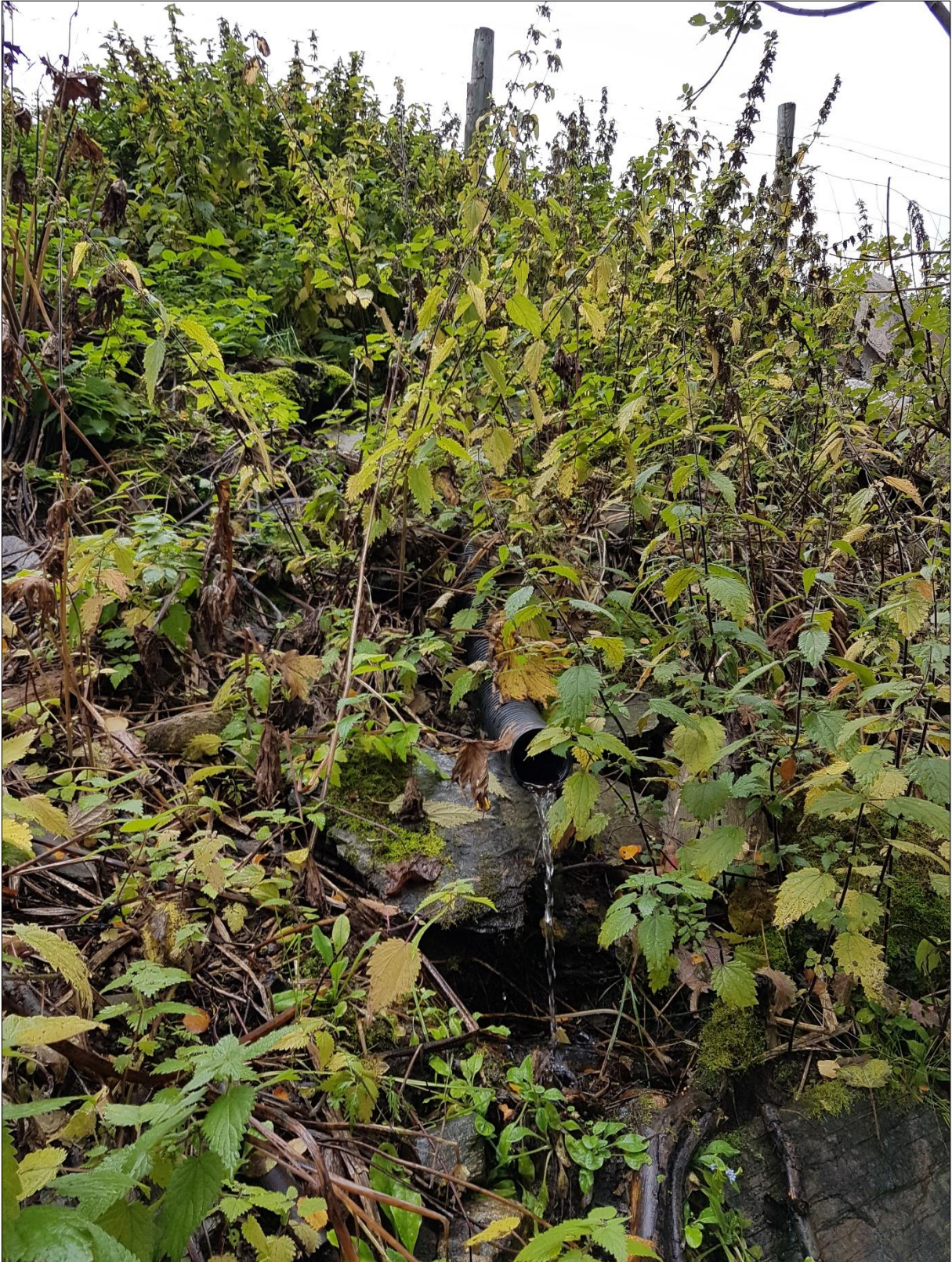
Figur 16: Stikkrenna frå røyrt/grøft som kjem frå dyrka mark på Søre Liasætrin. Stikkrenna kjem ut i toppen av ei skråning med mellom 30-40° helling. Krittisk punkt nr 3.
